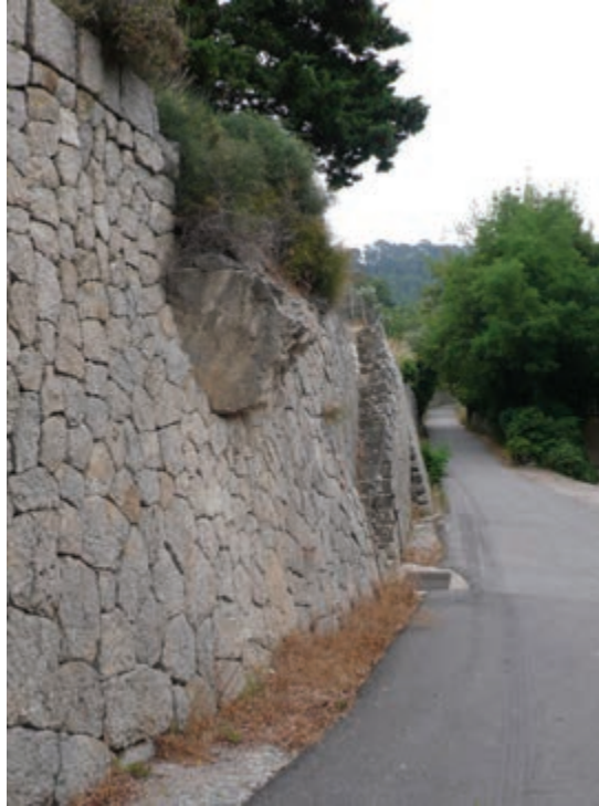
Figura 23. Las carreteras de la Serra están flanqueadas frecuentemente por muros de piedra en seco
