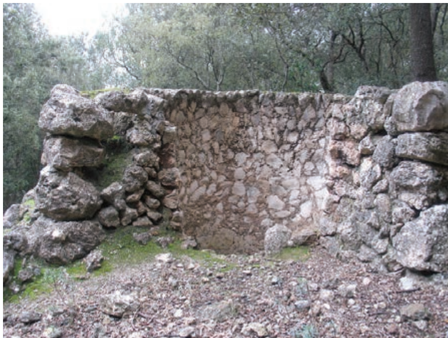
Figura 11. Horno de cal. El carbón permitía la obtención de cal.
