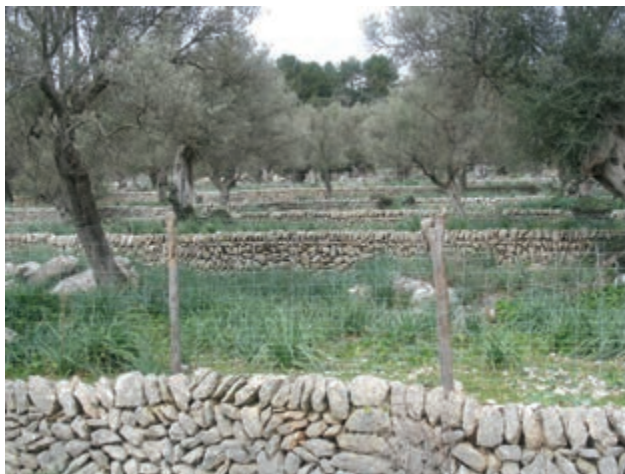
Figura 21. Las escuelas de margers han formado profesionales capaces de conservar la técnica de piedra en seco.
